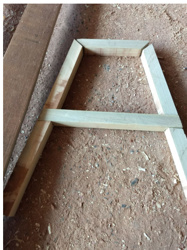
Figura 8 – Construção do cavalete
