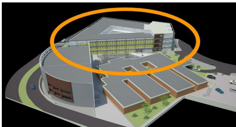
Figura 5 - Expansão, vista Bloco II (BOAS, 2010).
