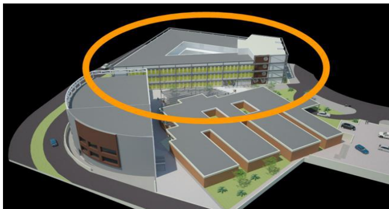
Figura 5 - Expansão, vista Bloco II (BOAS, 2010).
