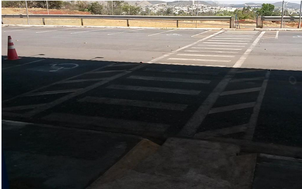
Figura 10 - Rampa de acesso às dependências da instituição
