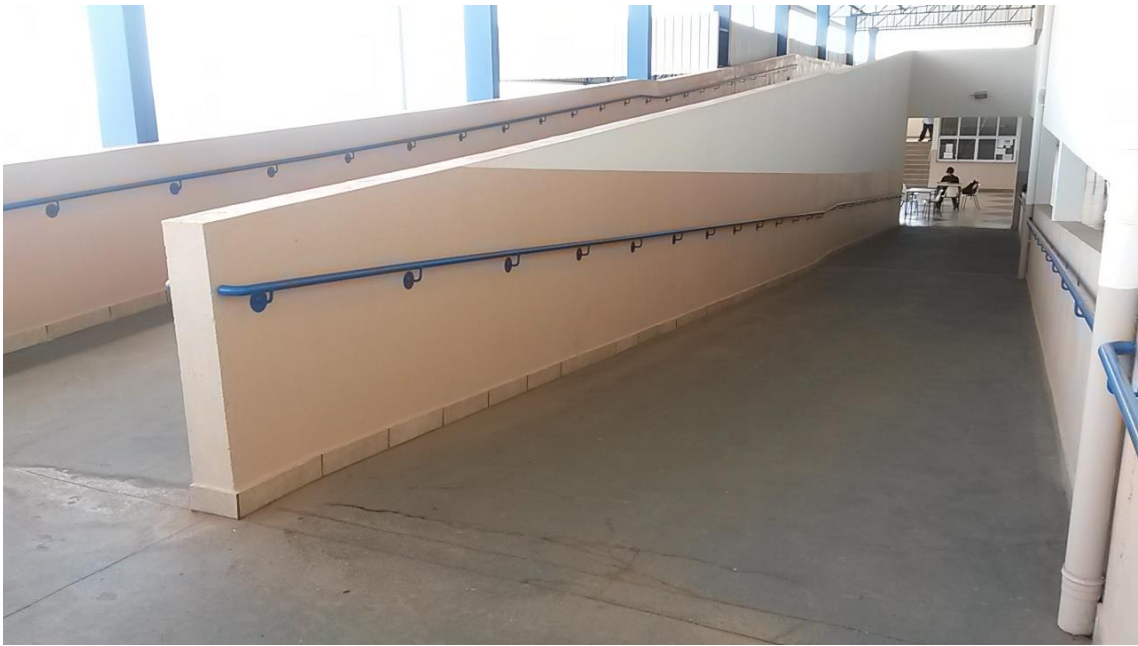
Figura 6 - Rampa de acesso ao segundo andar
