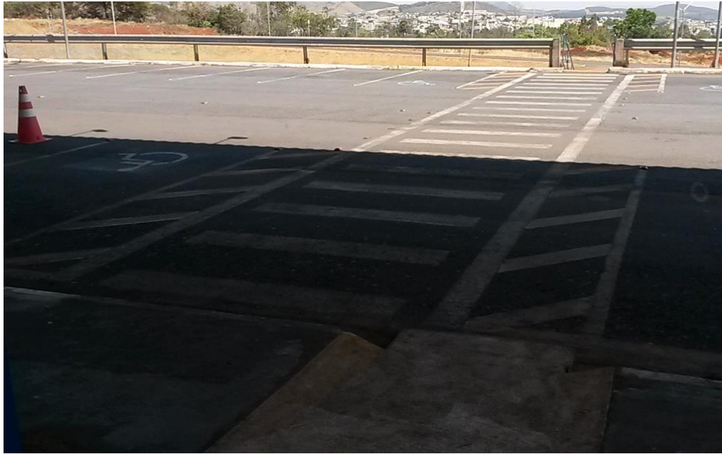
Figura 10 - Rampa de acesso às dependências da instituição
