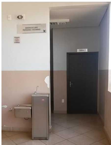
Figura 6 - Vista geral do banheiro para P.N.E
