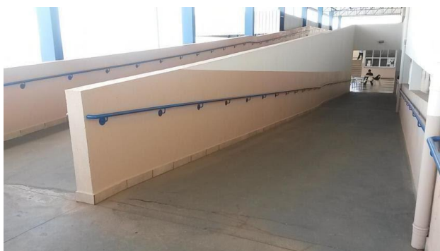
Figura 1 - Rampa de acesso ao segundo andar
