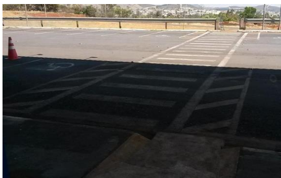
Figura 5 - Rampa de acesso às dependências da instituição
