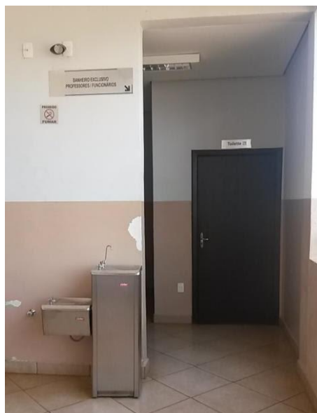
Figura 6 - Vista geral do banheiro para P.N.E
