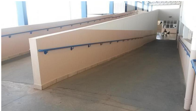
Figura 1 - Rampa de acesso ao segundo andar
