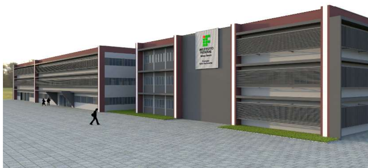
FIG. 06 - CONSTRUÇÃO DO BLOCO D DO CAMPUS SANTA LUZIA (SITUAÇÃO OBRA)
