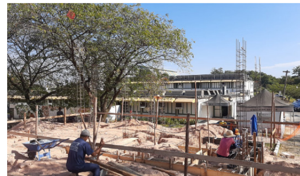
8. Portaria de Santa Luzia -Contrato 123/2022 Em andamento Valor da obra R$ 811.912,32
