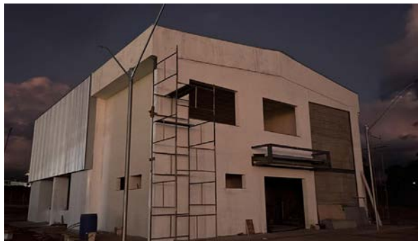
6. Obra Galpão de Ensino Campus Piumhi - Contrato 81/2021. Valor: R$1.853.092,36
