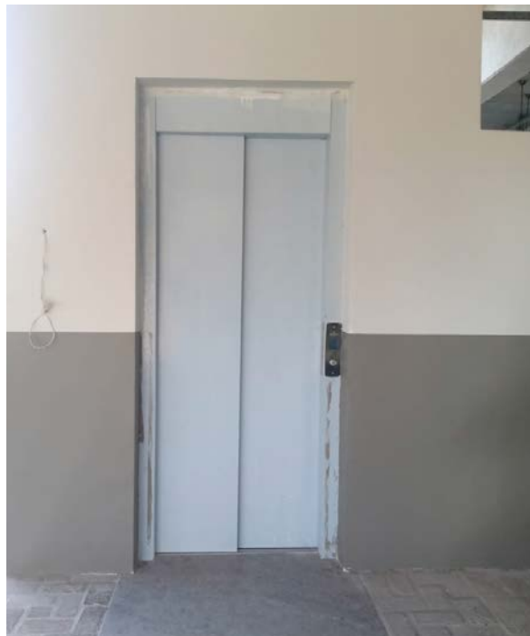
7. Elevador itabirito-Contrato 53/2022 Valor da obra - R$261.702,57 - Finalizada
