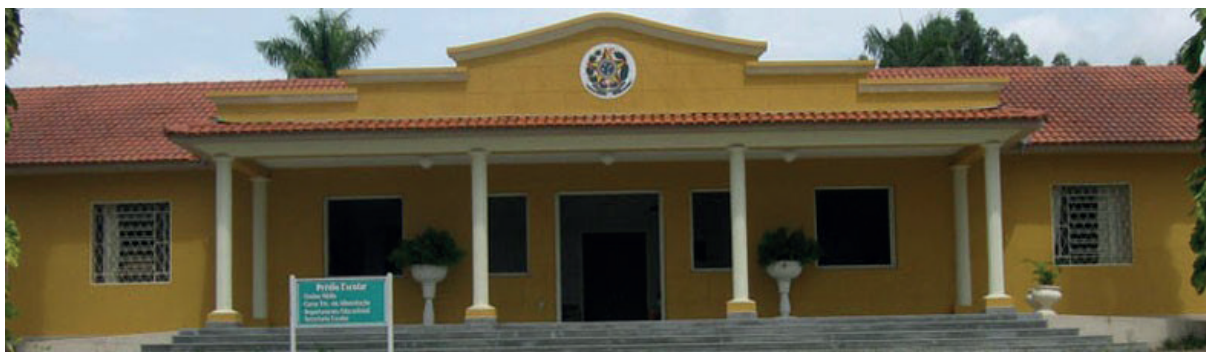
Figura 3 - Prédio de Aula Campus IFMG SJE
