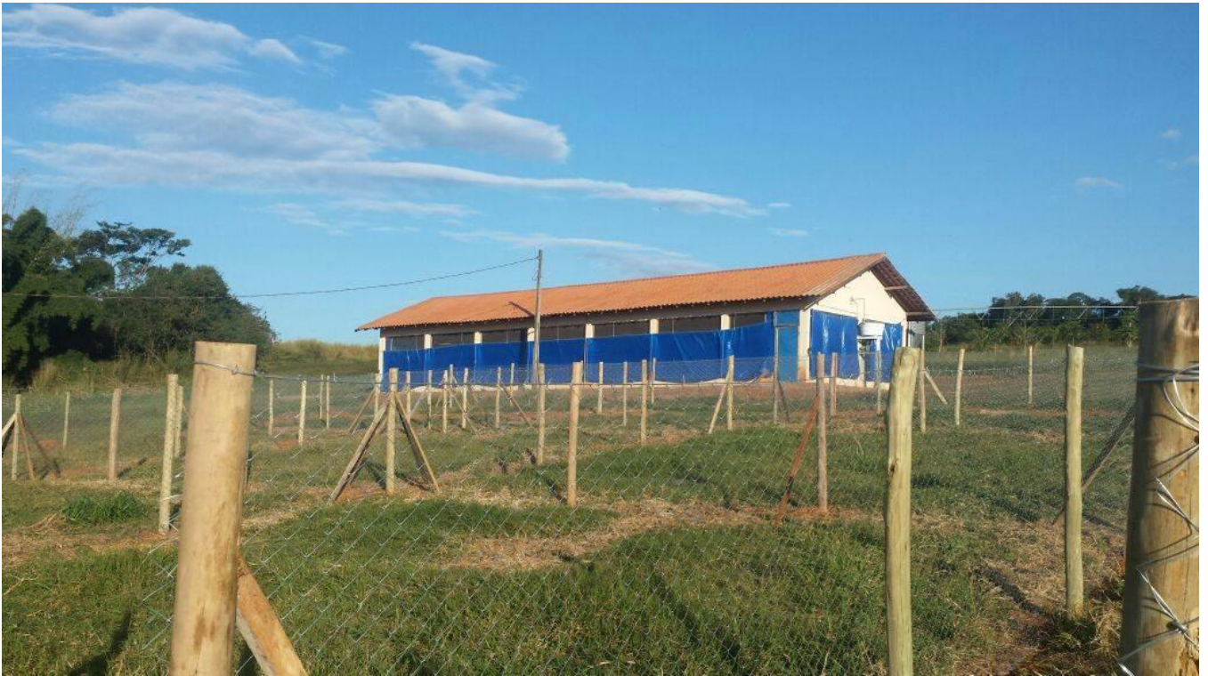
Figura 2. Área experimental em construção (piquetes)
