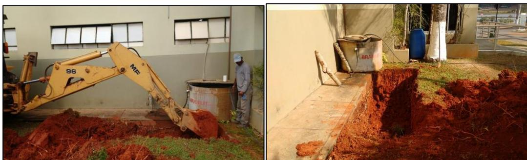
FIGURA 4: Instalação do sistema de reaproveitamento de água no LAS.
