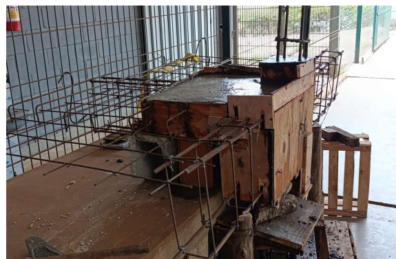
c) Fim da concretagem
