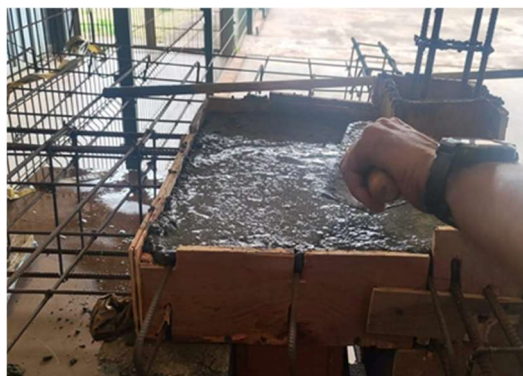
a) Início da concretagem
